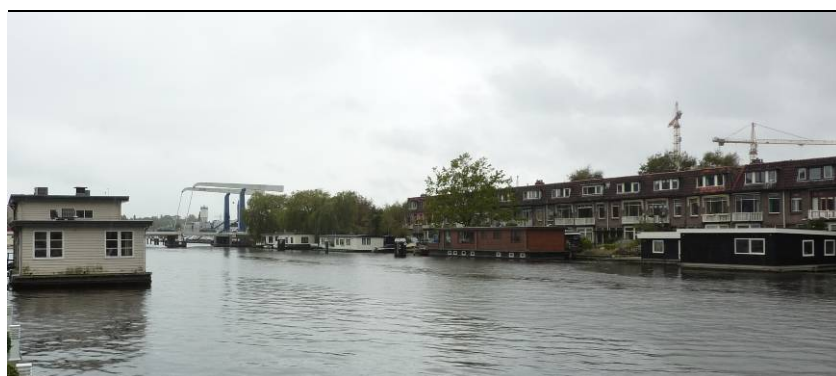
Figuur 3.9 Oude Rijnzone met op de achtergrond de passage van de N206 middels een brug
